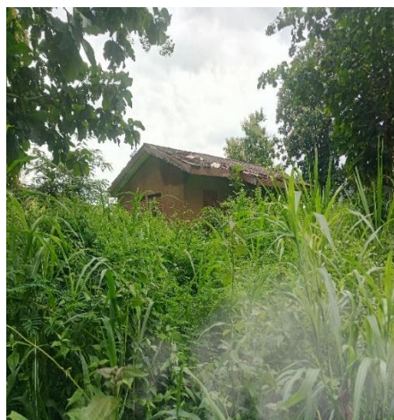
APERÇU DU POSTE DE GOUANÉ ENHERBÉ
