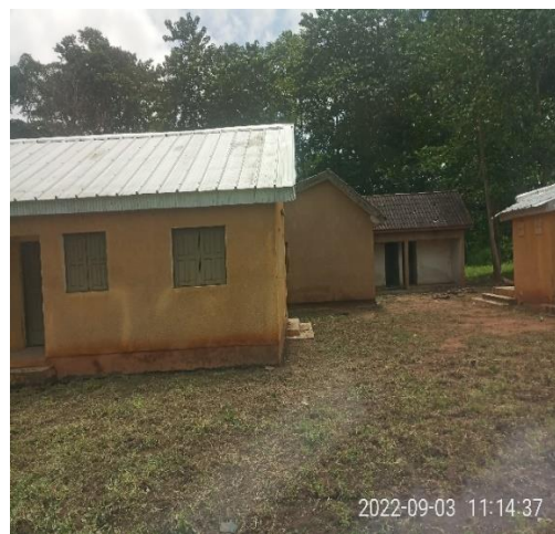
BATIMENT RÉHABILITÉ DU POSTE DE CONTROLE DE TOULO
