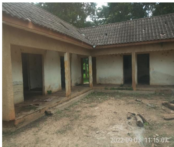
BATIMENT DU POSTE DE TOULO À RÉHABILITER
