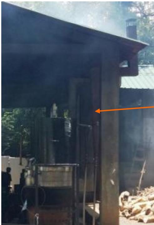
Les conduits de fumées métalliques non isolés souvent de forme carrée faute de rouleuse présentent quelques défauts.
