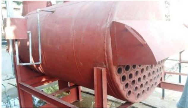
Chaudière en cours d'installation sur le site de Zara Voyage à Andrafia (Nosy Be). Le parcours des gaz de combustion passera d'abord en dessous de la cuve cylindrique et fera un demi-tour à travers les tubes de fumées pour être évacués par le conduit de fumées en arrière plan de la photo.
