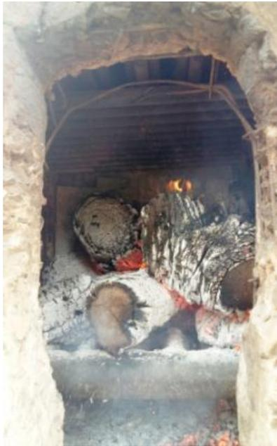
Vue sur le foyer de combustion de la chaudière auto-construite sur le site de S2A à Ambanja. Débit vapeur 0,8 T/h pression max 8 à 10 bars
