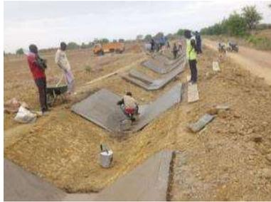
Si le revêtement des canaux devait devenir la norme, cela s'accompagnerait de plus grandes exigences dans l'exécution (par exemple pour la réalisation des joints bitumineux et le respect des pentes) et d'un accroissement des coûts/ha car le revêtement en béton dosé à 300 kg (y inclus fers, joints, etc.) sur une épaisseur de 0,10 m coûte de l'ordre de 23 000 FCFA/m<sup>2</sup>.
