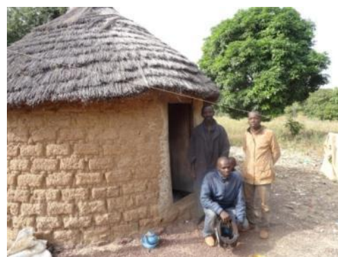
Case de stockage vers Kankan (Auteurs, 2015)
